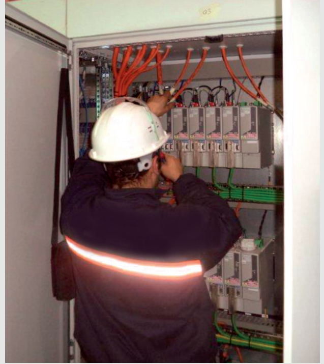
Elektrik Bakım - Montaj - Kontrol
