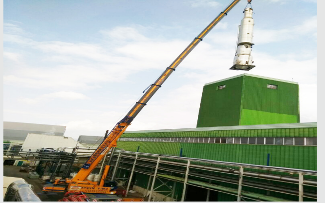
Kimya (Deterjan) Üretim Tesisi Demontajı ve Yeni Yerine Kurulumu
