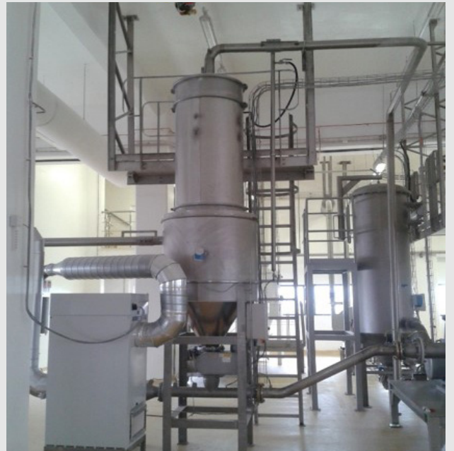
Gıda Tesisi Ekipman İmalatı Montajı ve Borulama İşleri
