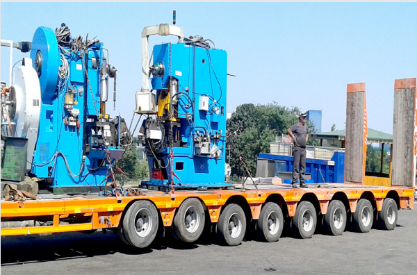
Pres Hattı Demontajı ve Yeni Türkiye'ye Yerine Kurulumu
