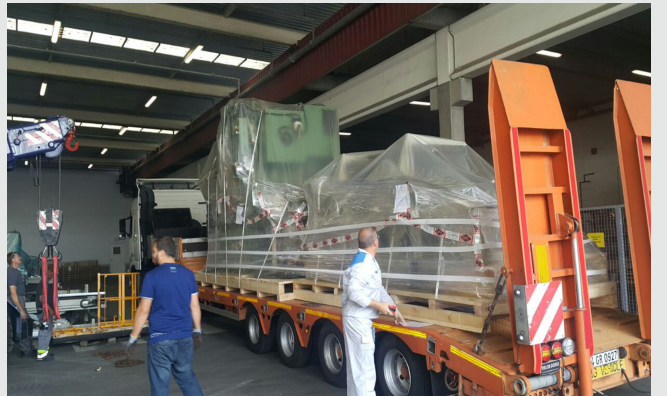
Klima Üretim Tesisinin Belçika'dan Demontajı ve Kurulumu
