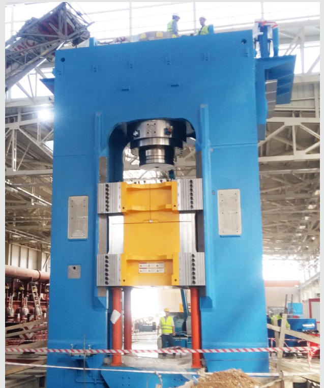
Pres Bakım Montaj Çalışmaları
